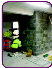
Aménagement des archives à La Poste
