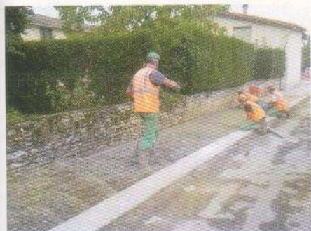
La mise en forme des trottoirs
