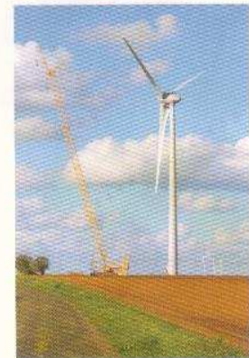
Eoliennes de Souvigné en construction
