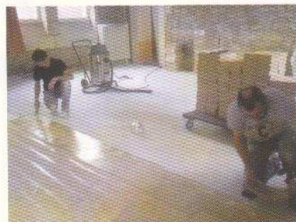
Pose du parquet
