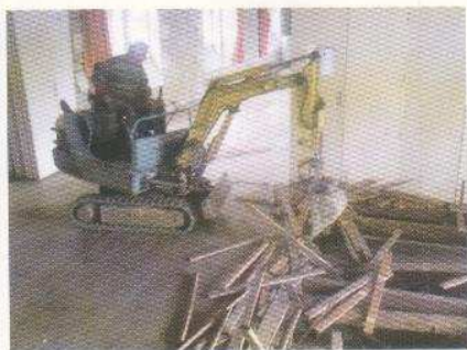
Début des travaux
