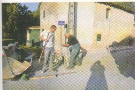
Pose des bordures
